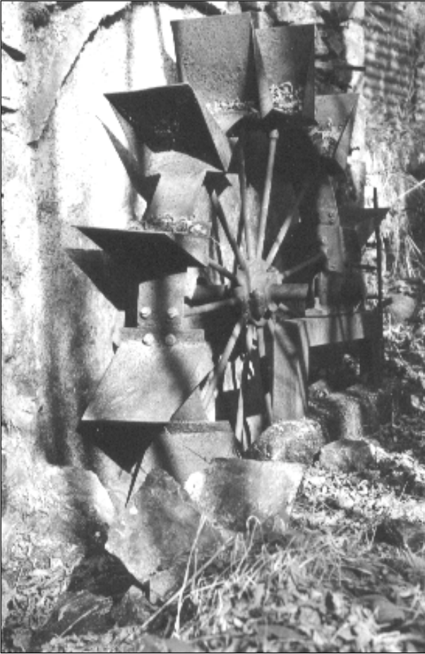
Moulin des Fontanes : la roue à aubes métallique
