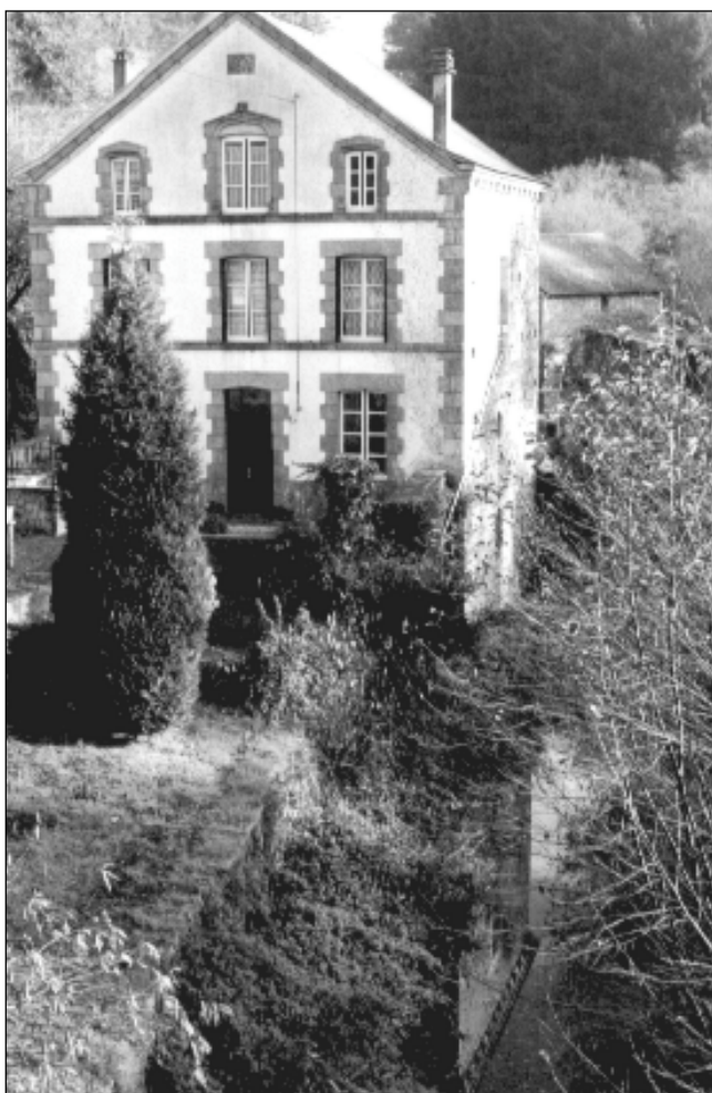
Le moulin, devenu une maison d'habitation, se reflète toujours dans les eaux de la Combade. On remarque, apparents, les matériaux venant de l'ancienne église de Sainte-Marie. On distingue, en bas du bâtiment côté rivière, l'emplacement de la roue.
