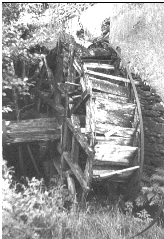
Moulin de Gannevieille : la roue à augets Photo Fernand Gaudy - 1972
