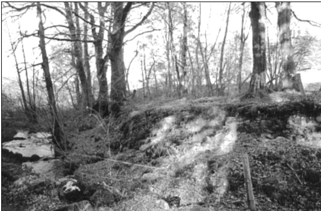
Moulin de St-Priest les Vergnes : on distingue les ruines du moulin à droite, le ruisseau des Vergnes à gauche et entre les deux on devine la voûte et le passage de l'eau qui revient dans le ruisseau
