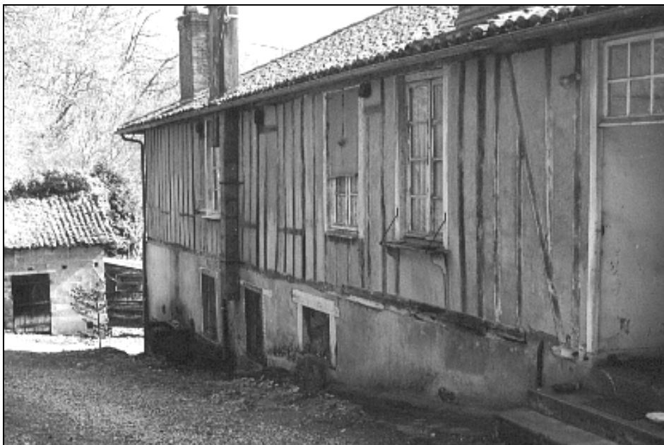
L'arrière du bâtiment
