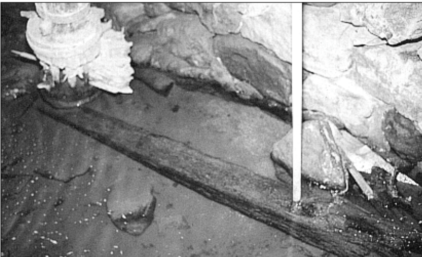
Moulin de Villevalaix : au niveau de la voûte, restes des roues à cuillers, coursiers et épée de trempure
