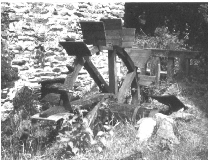
La roue à aubes du moulin de Soumagnas
