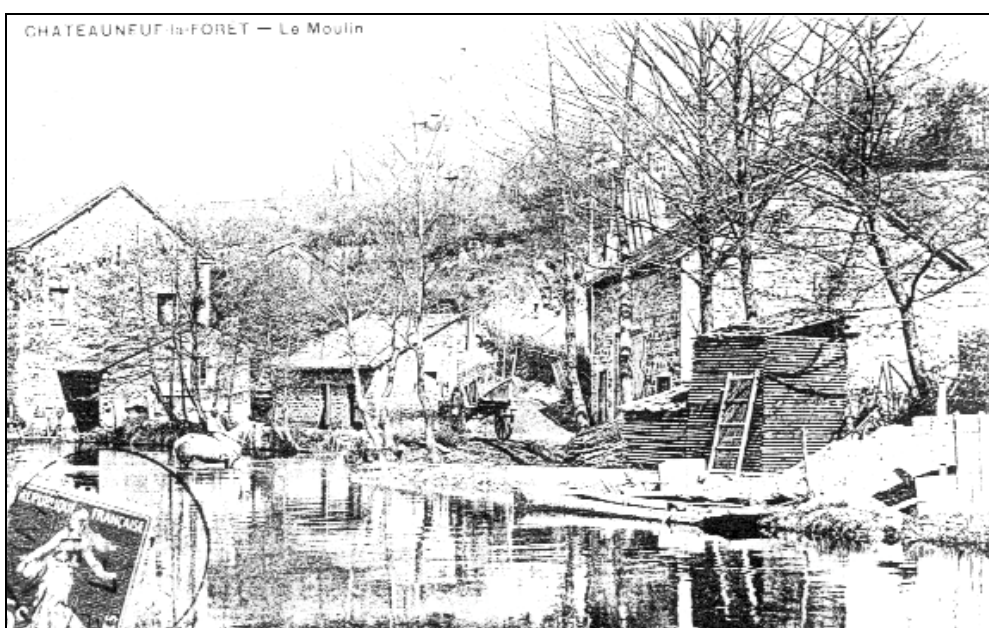
Le moulin au temps de la parqueterie coomme le laissent supposer les tas de planches (d'après une carte postale ancienne)
