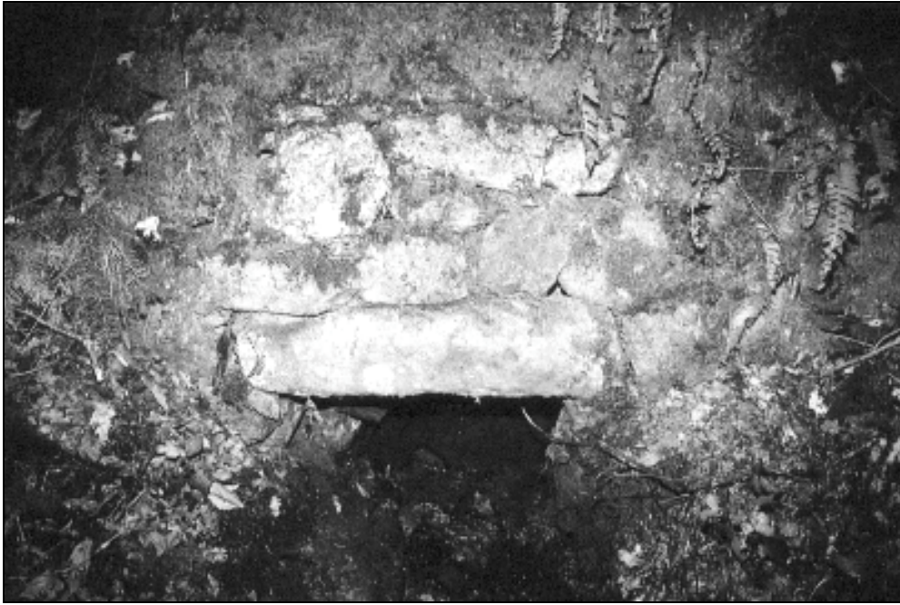
Moulin de St-Priest les Vergnes : la voûte, très visible, dans sa couronne végétale
