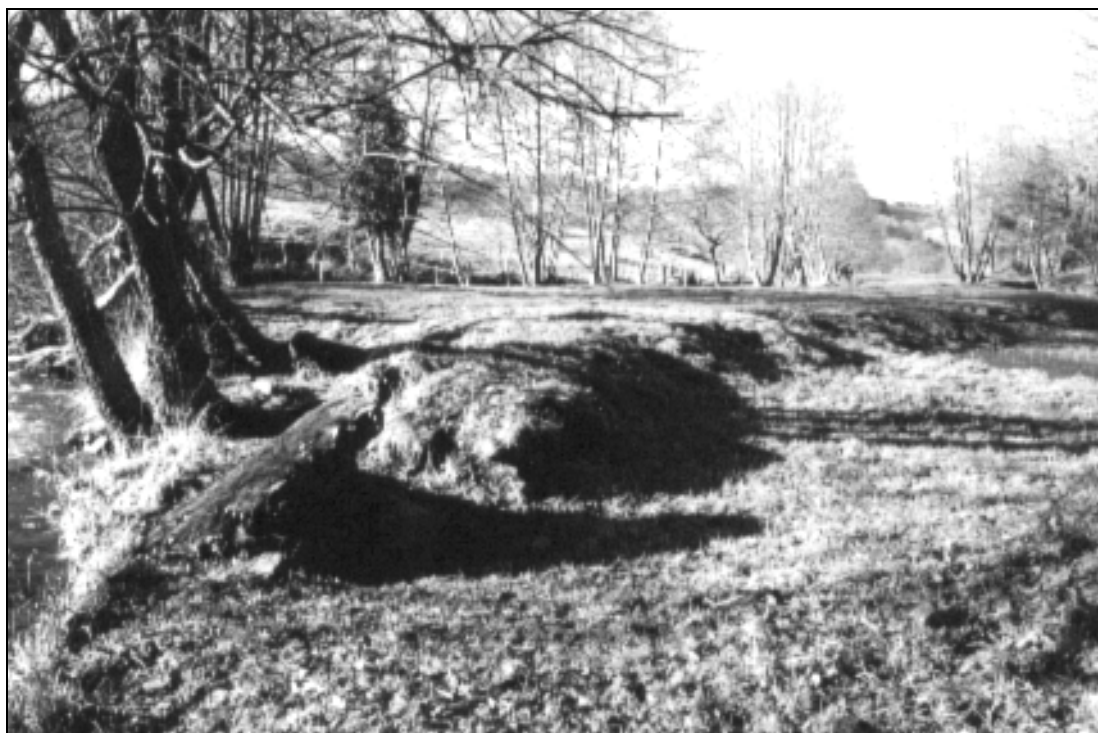
Moulin de Valluaud : le départ de la levée avec à gauche la Combade et sur la rive un bloc de maçonnerie signalant la consolidation du confluent
