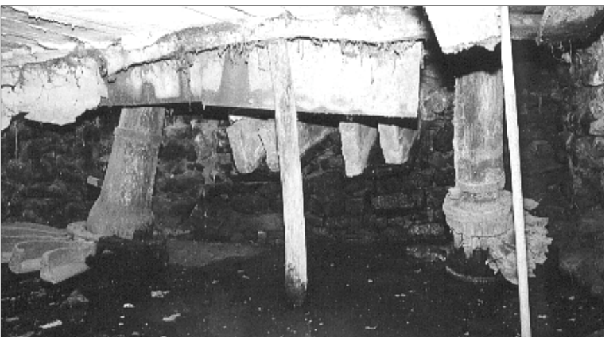
Moulin de Villevalaix : encore fixée sur la roue la plus endommagée, on distingue fort bien la trempure et son épée
