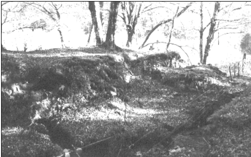
Moulin de St-Priest les Vergnes : on distingue à gauche la voûte, au centre le retour de l'eau et à droite le ruisseau des Vergnes
