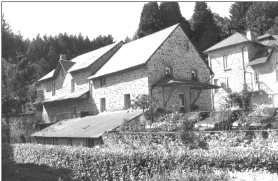
Une vue actuelle de l'ancien moulin du Roc transformé en bureaux de l'entreprise "Madrangas-Vialle" Si, par rapport à la photo de la page 33 prise en 1938, les modifications du bâtiment ne sont pas importantes, on peut remarquer de grandes différences dans la végétation.
