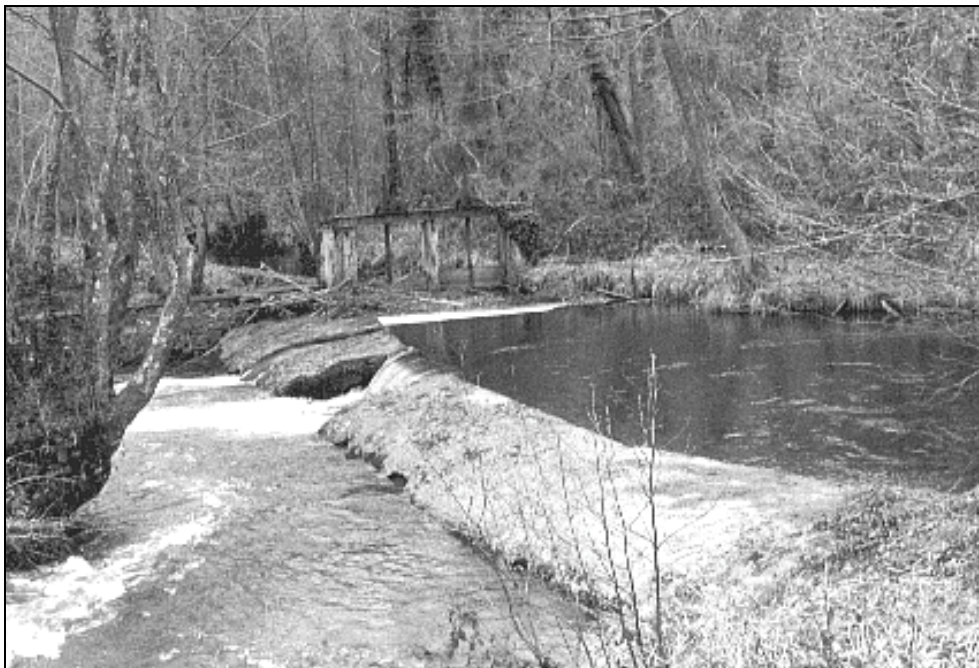
A une cinquantaine de mètres en aval du pont, le barrage sur la Combade avec son pertuis et le départ du canal vers le Moulin Neuf.
