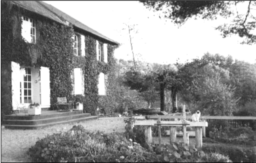
Le moulin des Ribières de nos jours ; au premier plan, le trop plein (d'après une photo aimablement prêtée par Mme Robert)
