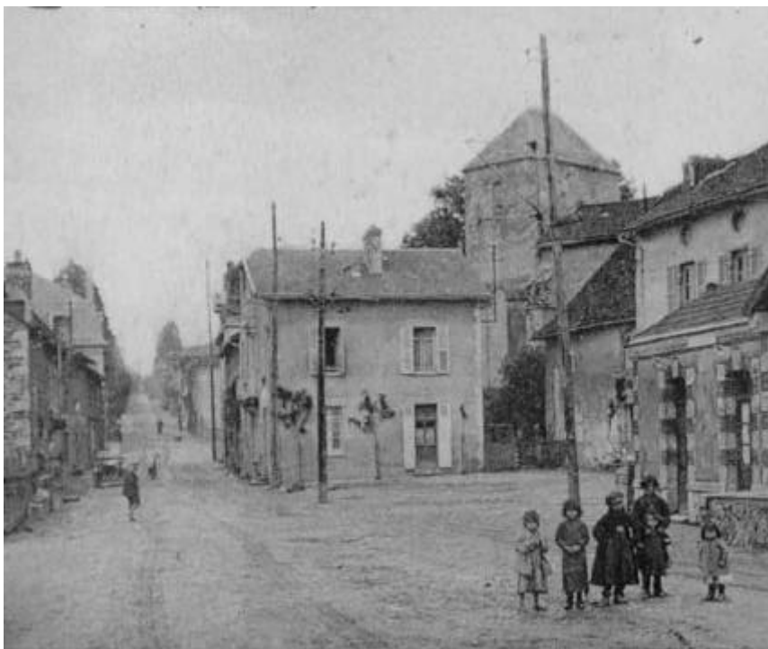
La poste n'a pas subi de modifications extérieures significatives depuis sa construction en 1910.
